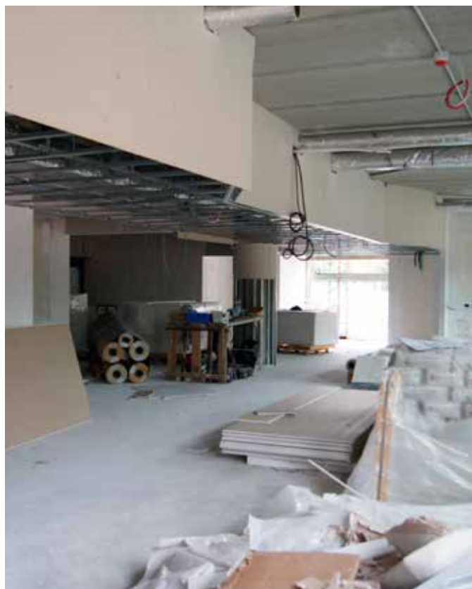
Il cantiere è operativo.
